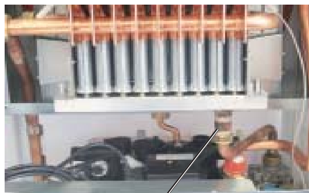
Накидная гайка Подвод газа [4]
