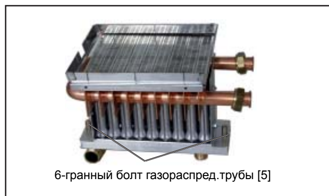
Рис: Демонтаж компонентов горелки
